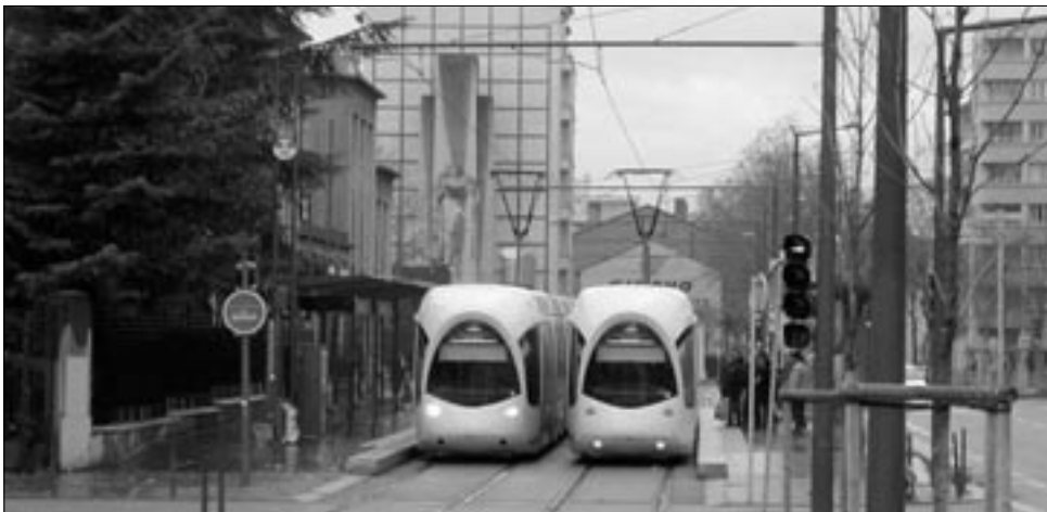
Le site propre et les arrêts du tramway de Lyon (ici, implantation latérale sur la voie).
